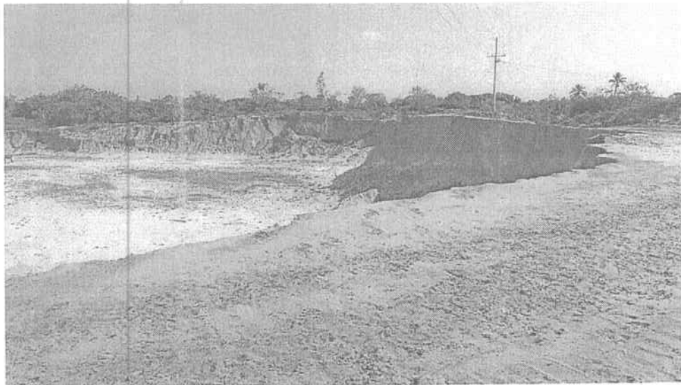
Figura 1. Vista de taludes: se observan taludes perpendiculares. Fuente: C.R.A.
